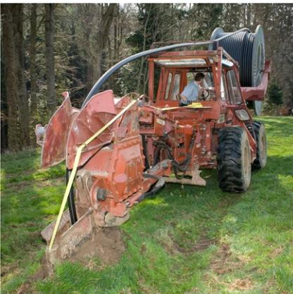
Beim Einpflügen wird mit einem Pflug ein Verlegeschlitz in den Boden gepflügt. Der Boden wird durch Verdrängerelemente auseinandergedrückt, gleichzeitig wird das Rohr eingebracht. Der Hohlraum kann mit Sand oder feinem Bettungsmaterial ausgefüllt werden, jedoch findet keine zusätzliche Verdichtung statt. AQUALINE RC-Rohre von Pipelife erfüllen diese Beanspruchung mit einem Höchstmaß an Sicherheit. Das Pflügen stellt wohl die wirtschaftlichste Neuverlegung von Kunststoffrohren dar.
