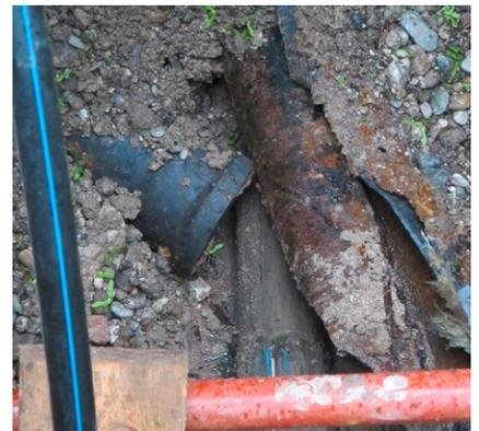
Beim Einziehen von AQUALINE RC ROBUST-Rohren sind geeignete Maßnahmen zu treffen – zum Beispiel eine Hülse – um zu verhindern, dass die Einzugskräfte auf den freien Querschnitt des Schutzmantels wirken können.
